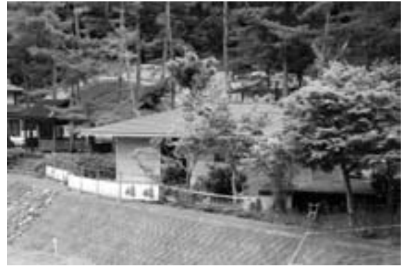
▲交流センター前の公衆トイレも新しくなります
