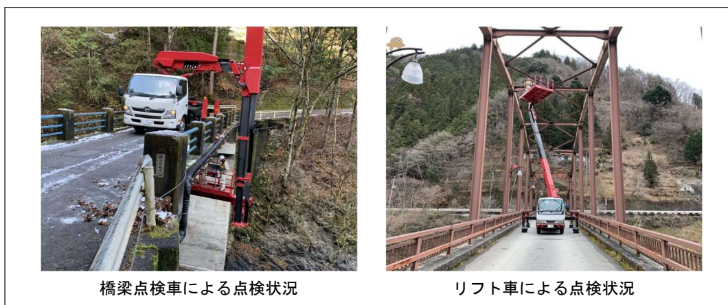
写真 2.2 定期点検状況
