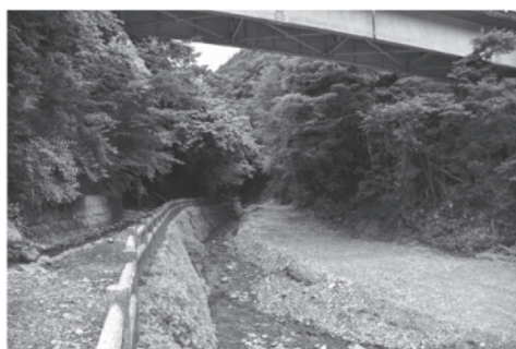
▲河川復旧工事（貝沢川）
