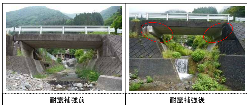
写真 2.3 修繕・補強等の実施例
