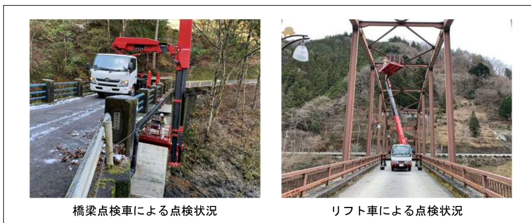
写真 2.2 定期点検状況
