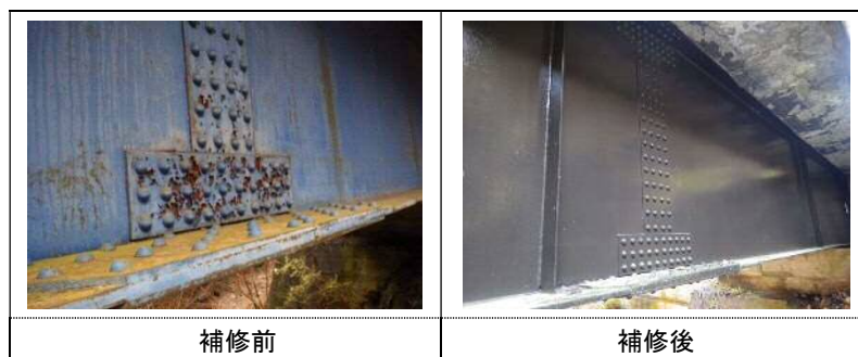
写真 1.1 補修状況写真 (No. 12_羽根戸橋 鋼部材塗装塗替え)
