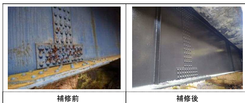
写真 1.1 補修状況写真（No. 12_羽根戸橋 鋼部材塗装塗替え）
