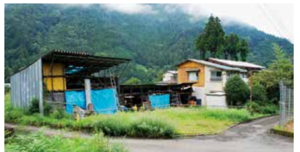
▲高尾地区の定住促進住宅建設予定地
